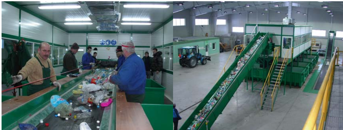
Fot 2. 6. Linia technologiczna sortowania odpadów użytkowych
