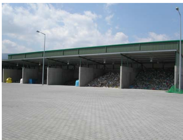
Fot 2. 9. Magazyny zewnętrzne na odpady
