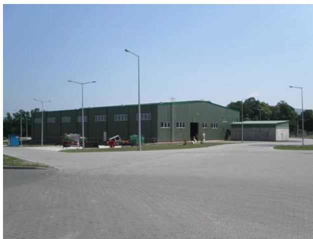
Fot 2. 2. Widok na Karkonoskie Centrum Gospodarki Odpadami
